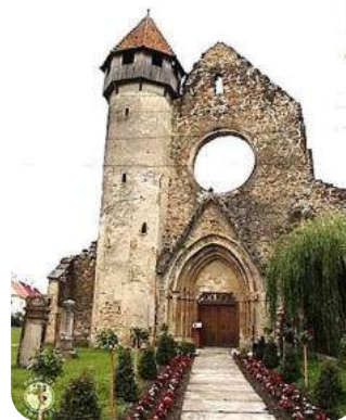
Fereastră rotundă specifică mănăstirilor cisterciene, amplasată deasupra portalului. Vechea Mănăstire de la Cârța
